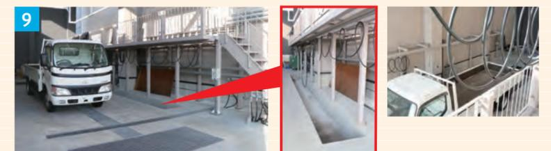
▲大型車用洗車場は下部洗浄と上部洗浄機を導入し、高所作業スペースに洗車ホースを設け(右画像)補助的な洗浄も可能。片側にピットを設けることで、かがむことなく洗車作業ができ、作業者の負担を軽減
