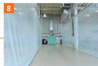
▶架装ストールは下回りの塗装を実施する際のミスの飛散を防止するためカーテンを設備するとともに排気装置を設置
