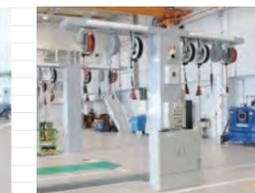
▶“自立式リール架台”の導入で、天井走行クレーンの可動範囲を拡大
