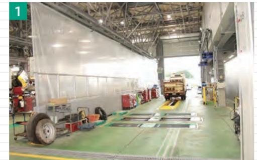
▲車検整備ストールで塗装をする際の粉じん防止としてカーテンレールを設置
