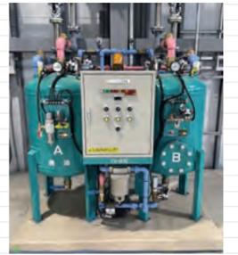
▲工場上部に巡らせた配管から廃液を回収する“FVシステム”。廃油タンクまわりの汚れや漏れを防止
