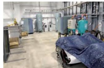
中2階にコンプレッサーや廃油・廃液処理システム“FVシステム”を配備
