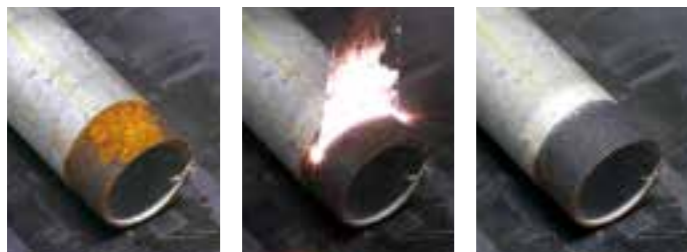
施工前 錆びたねじ山にレーザークリーナーを施工 施工後
