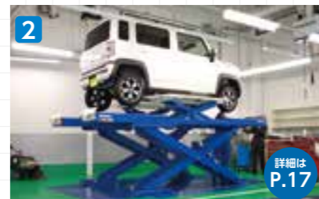
2 クイック整備に適したドライブオンタイプの“マルチリフト”(上)と下回り点検が容易なパンタ式の“ステイタスリフト”(右)を各2基導入
