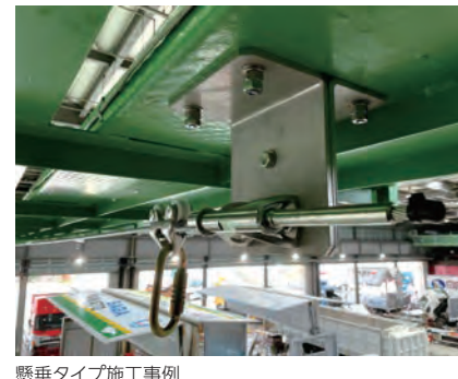
懸垂タイプ施工事例
